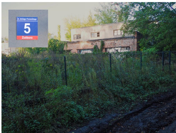
Ryc. 1 Relikty dawnych zabudowań przy błotnistej drodze na tyłach posesji przy ul. Elbląskiej 5, 2025 rok. Nowoczesny budynek od frontu ma już zmienioną tablicę adresową na Ficowskiego 5
